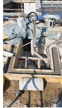
Continuazione demolizioni e modifiche per vano montacarichi
