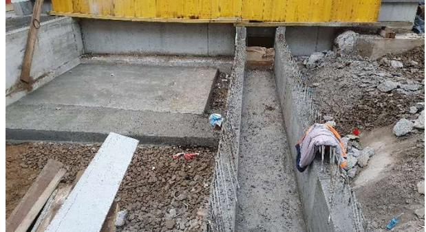
Continuazione demolizione per vano lift
