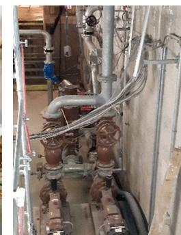
Prova di tenuta decantazione primaria linea 1 nuova
