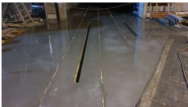
Avanzamento lavori per canali, pozzetti, biologia e decantazione finale
