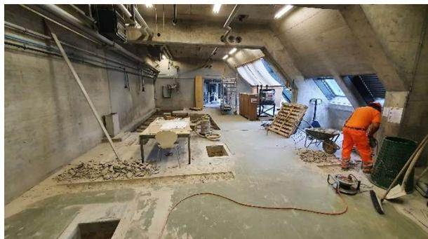
Posa vasi d'espansione, batteria di distribuzione sanitari e smontaggi esistente
